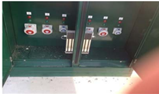
Afb. 5. Walstroominstallaties in de wachthaven van Wijnegem
