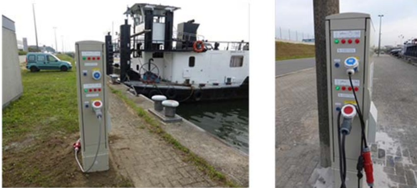
Afb. 3. Walstroominstallatie in de haven van Antwerpen
